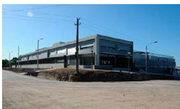
Figura 2. Vista del complejo destinado a la Escuela Técnica Santa Catalina
