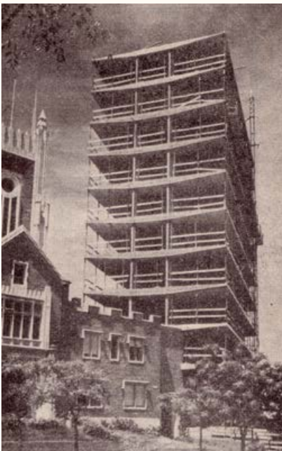
Edificio Positano. Arquitectos Luis García Pardo y Adolfo Sommer Smith. Av. Luis P. Ponce y Charrúa. Montevideo, 1959 (proyecto final). Proyecto estructural: Losas formadas por placas prefabricadas que descargan en dos vigas longitudinales, un núcleo estructural central y dos pilares en forma de doble T, dejando el plano de fachadas libre de pilares. El resultado en planta baja es el efecto despegado del suelo del bloque vidriado.
