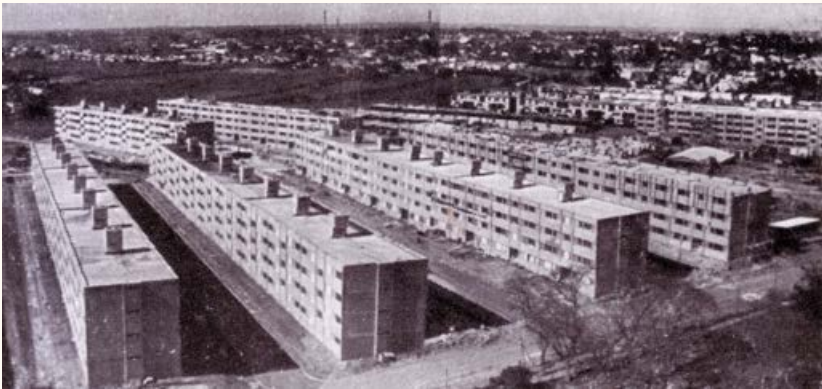
Sistema PNV para la construcción de vivienda de interés social. Complejo Malvín Norte, Montevideo, 1975, con arquitecto Homero Pérez Noble. Sistema prefabricado de piezas de hormigón liviano, ancladas in situ en estructura de hormigón armado.
