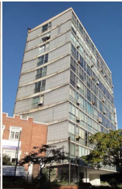
Edificio Positano. Arquitectos Luis García Pardo y Adolfo Sommer Smith. Av. Luis P. Ponce y Charrúa. Montevideo, 1959 (proyecto final). Proyecto estructural: Losas formadas por placas prefabricadas que descargan en dos vigas longitudinales, un núcleo estructural central y dos pilares en forma de doble T, dejando el plano de fachadas libre de pilares. El resultado en planta baja es el efecto despegado del suelo del bloque vidriado.
