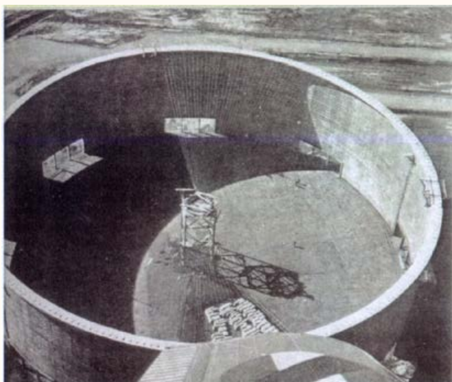
Tambor circular coronado por pieza de hormigón para anclaje de cables.
